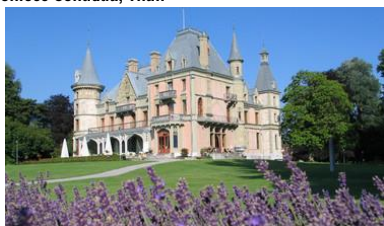
Umbau Schloss Schadau, Thun
